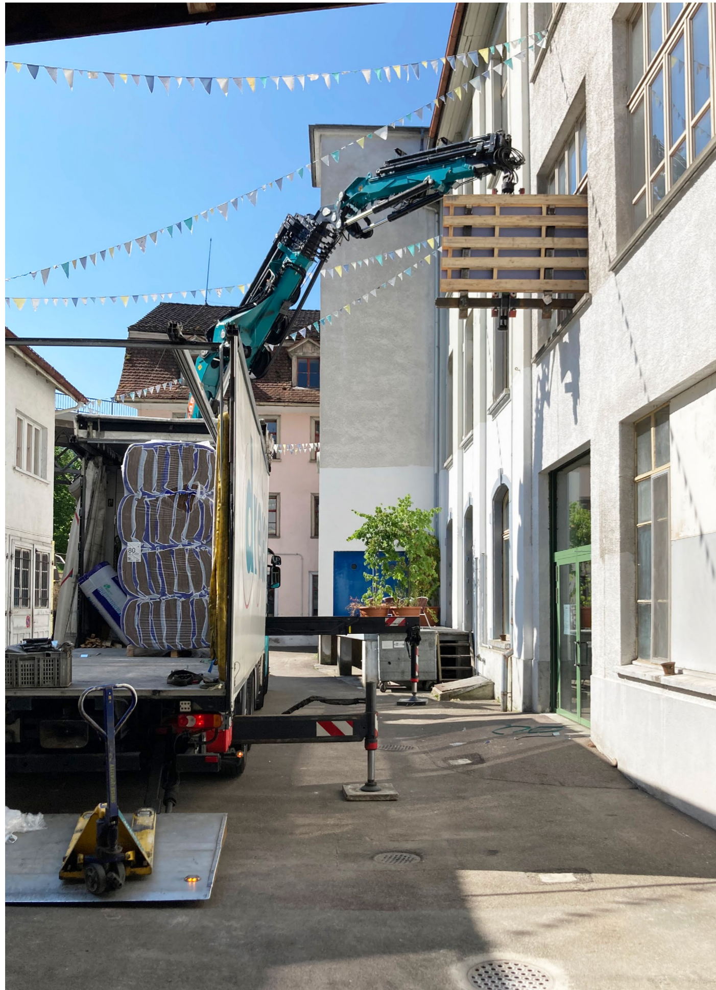
Anlieferung von Baumaterialien
