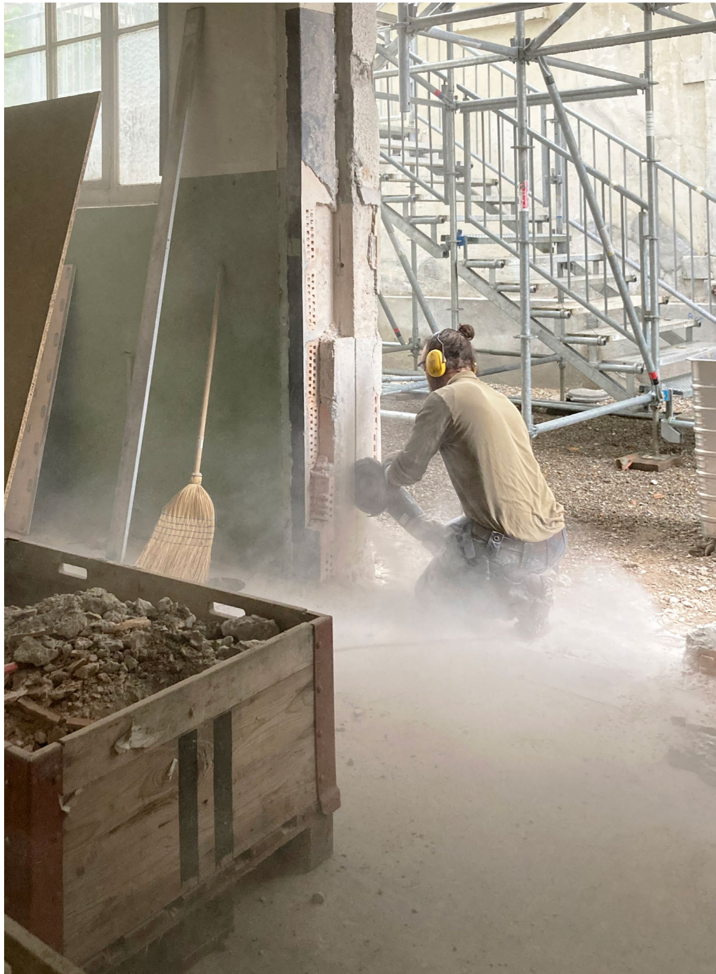
Ausschneiden der Türen zum Erdgeschoss im Nordbau
