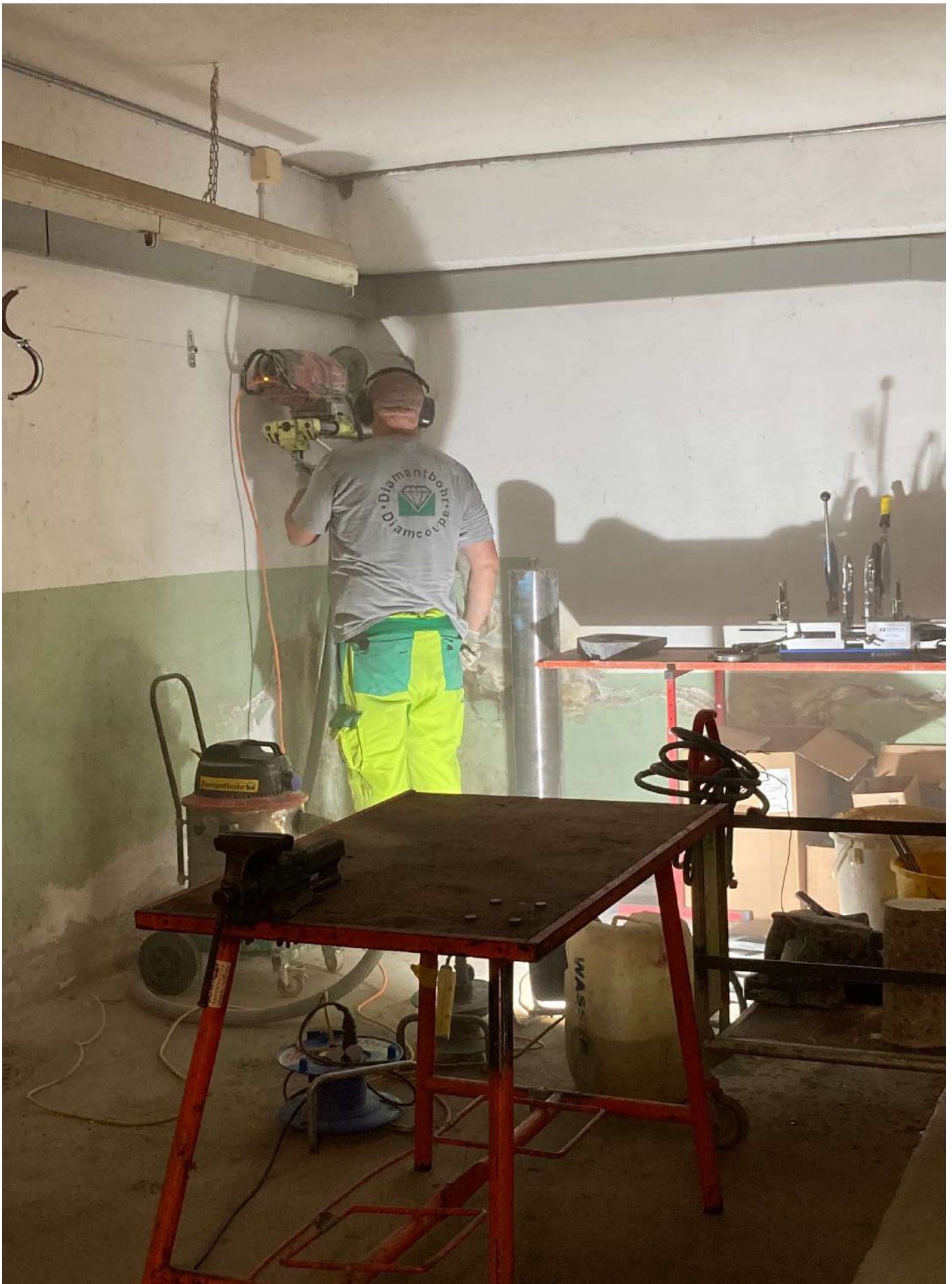
Baubeginn: Erste Bohrungen im Untergeschoss
