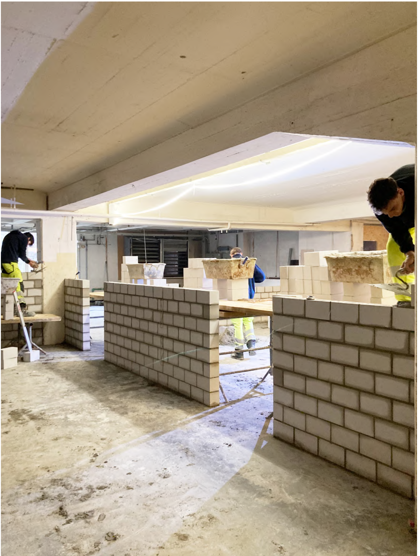
Im Untergeschoss entstehen neue Räume
